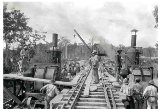
Figura 3. Construcción de las vías del ferrocarril Madeira-Mamoré - 1909-1011. Foto: Dana Merrill. Fuente: Carvalho & Lima (2000).
