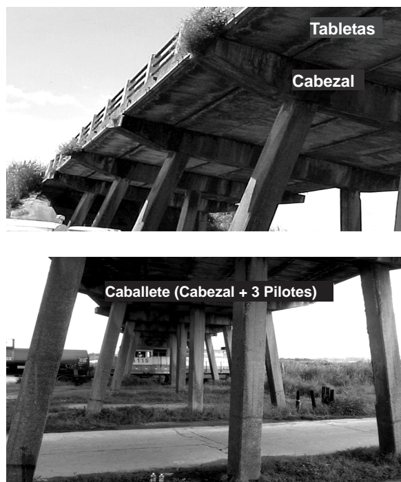
Figura 1. Componentes del Puente
