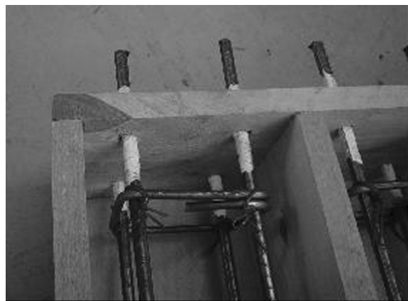
Figura 3. Detalle de protección del acero de refuerzo y armado de cimbra
