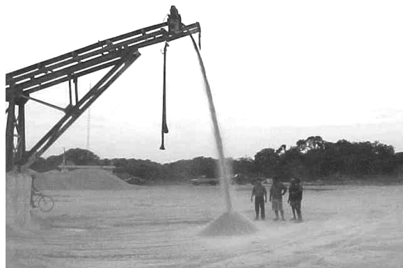
Figura 4. Apilado de los nuevos agregado
