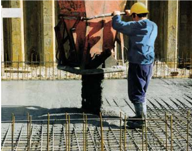
Fig. 1.- Colocación del Hormigón Autocompactante en losas.
