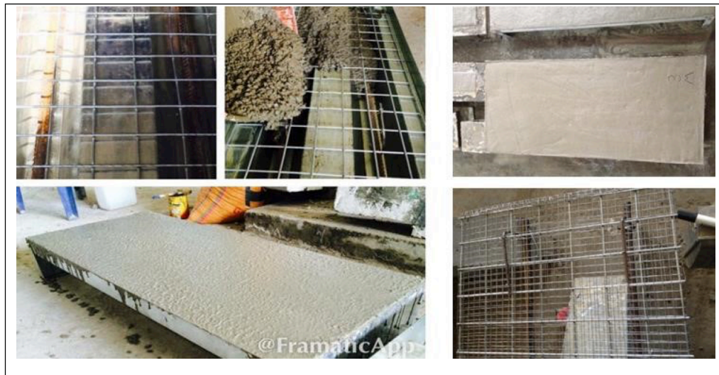
Figura 3. Colado de los paneles nervados de SCC y FER
